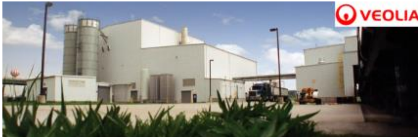
Figure 8 : Traitement des boues de la station d'épuration de Chicago (source : Veolia)
